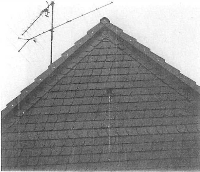
Abb. 2. Giebelwand nach der Verschieferung mit Einflugloch. Aufn.: CHR. BUCHEN, 25. VI. 1990
