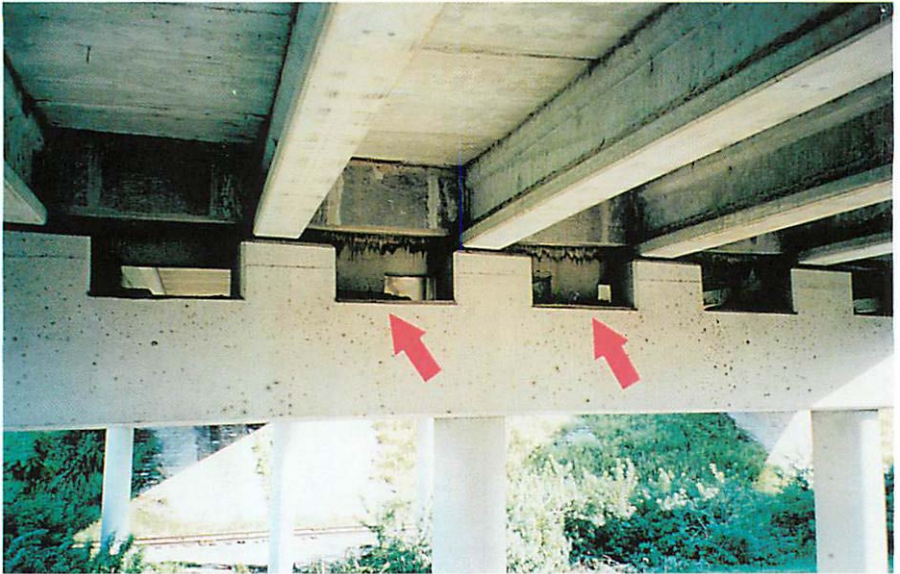
Abb. 3. Zwischen der Fahrbahnunterseite und den Trägern waren die Wände erheblich mit Urin und Kot versehen. Unterhalb dieser Stellen war die Betonkonstruktion durch Exkremente der Kolonie bedeckt.
