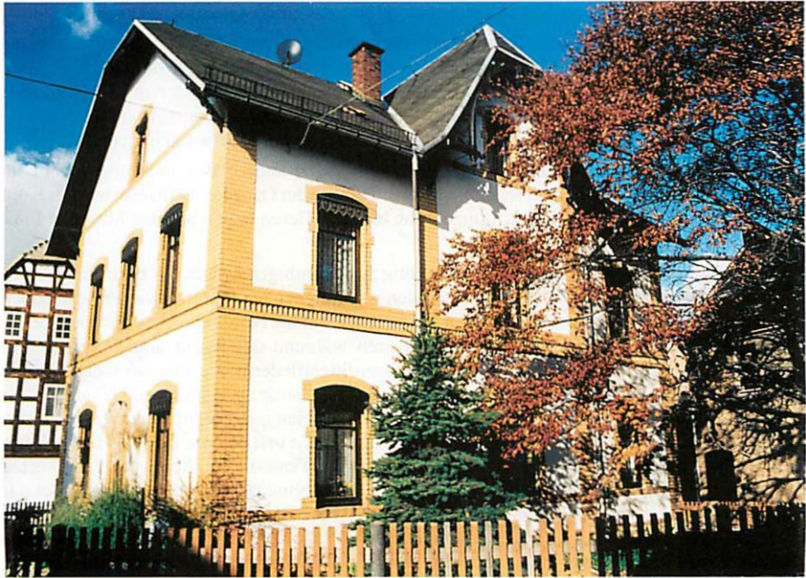
Abb. 1. Wohnhaus des Verfassers in Großenstein, Hauptstraße 36, in dem sich die beschriebene Wochenstube der Breitflügelfledermaus befindet. Aufn.: H. WEIDNER
