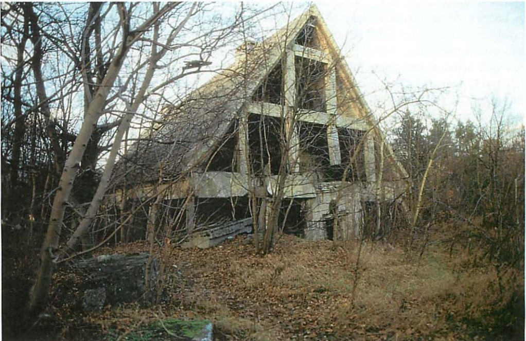
Abb. 1. Eines der gesprengten, doch äußerlich noch einigermaßen erhaltenen Häuser der Maybach-Bunkeranlage I. Aufn.: R. BAIER/Rangsdorf
