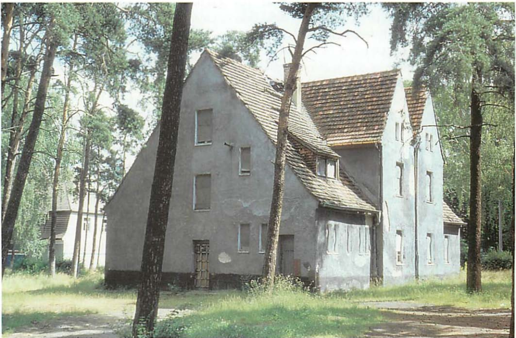
Abb. 8. Gebäude mit bereits vernagelten Fenstern und Türen in der Fliegerstadt M 3 kurz vor Abzug der Russen im August 1994. Beachteten Zustand des Hauses und den prächtigen wald-/parkartigen Charakter der Umgebung, der weite Teile des Kasernengeländes auszeichnet. Aufn. D. ARNOLD/Gottsdorf
