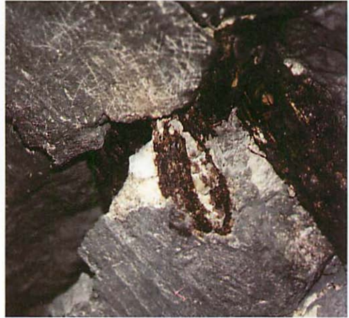
Abb. 14. Mopsfledermaus in durch Sprengung zerklüfteter Betondecke mit verrosteten Eisenbewehrungen in Maybach-Anlage I. Aufn.: DIRK STEINHAUSER, 7.III.1996
