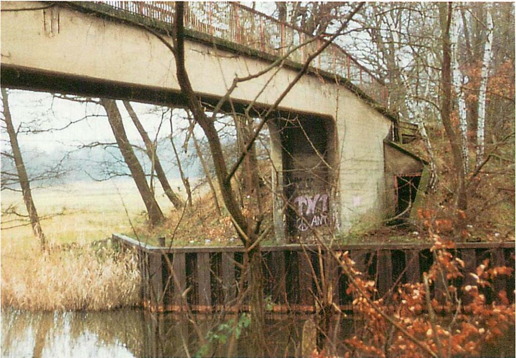
Abb. 5. Pintschbrücke Fürstenwalde/Spree. Rechts neben dem Pfeiler der zimmertürgröße, völlig offene Eingang in die Brückenkammer. Aufn.: LUTZ FITTERMANN, Dez. 1994
