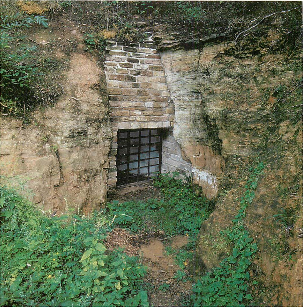
Abb. 1. Doppelverschluß eines Stollens, sichtbar erstes Gittertor mit verschiedenen Sicherungssystemen. Aufn.: BERND OHLENDORF
