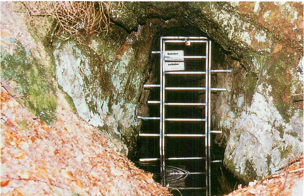
Abb. 3. Mehrere ehemalige Bergwerksstollen bei Morsbach wurden in den letzten Jahren mit speziell eingepaßten Gittertoren gesichert. Für die Kontrollen kann der innere Teil des Tores herausgenommen werden. Aufn.: C. BUCHEN
