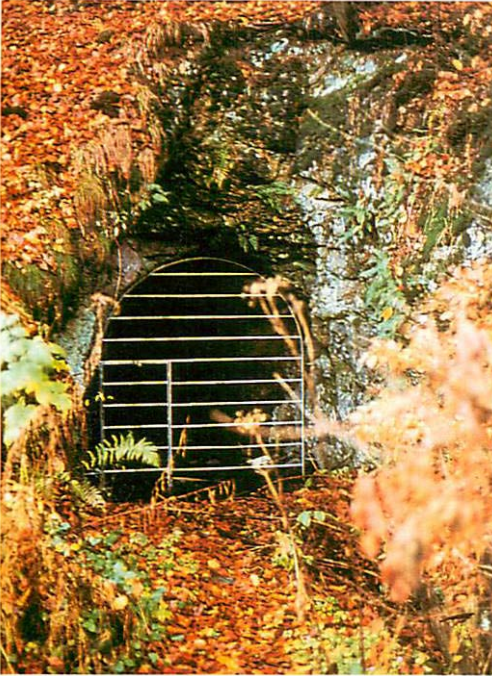
Abb. 2. Ehemaliger Bergwerksstollen bei Morsbach, der bereits 1980 mit einem Gittertor gesichert wurde. Der Fledermausfreundliche Verschluss trug zur Beruhigung des Stollens bei, und die Anzahl der Fledermäuse hat sich bis 1996/97 verdreifacht. Aufn.: C. BUCHEN
