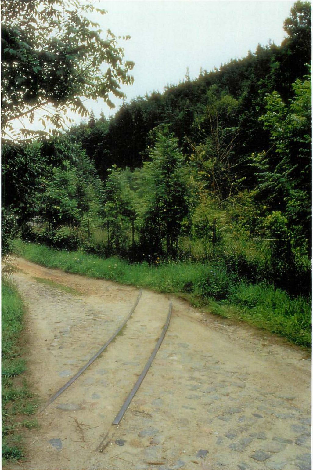
Abb. 2. Nahe der Jugendherberge im Hammertal findet sich ein letzter Rest des Huntengleises, das zum Alauntunnel führte. Aufn.: Dr. GÖTZ RUEMLER
