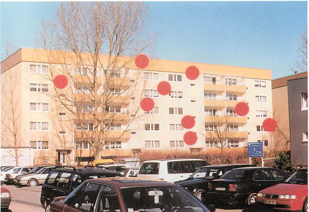
Abb. 12. Koszalin Str. 10-16 (Nordseite). Die Abbildung zeigt die Nordseite desselben Gebäudes mit einer deutlich geringeren Besiedelung von 9 Bereichen. Aufn.: A. GRIESAU
