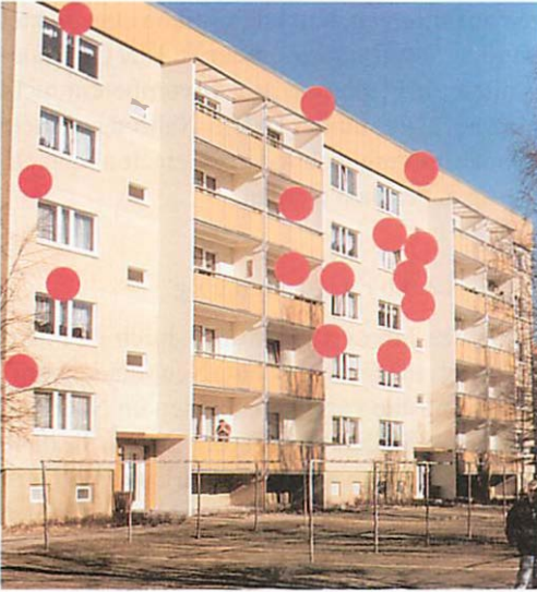
Abb. 11. Koszalin Str. 10-16. An diesem Gebäude konnten durch Kot- und Urinspuren insgesamt 24 Bereiche mit Fledermausbesatz festgestellt werden. Die Abbildung zeigt die Südseite des Gebäudes mit einer auffälligen Anhäufung der ehemaligen Fundstellen im Bereich des 2. bis 4. Stockwerkes. Aufn.: A. GRIESAU
