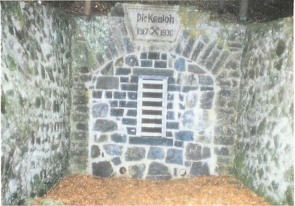
Abb. 16. Verschluss der Eisenerzgrube „Dickentloh“ in einem Ortsteil von Weilburg - Außenansicht. Aufn.: JOSEF KOETTITZ
