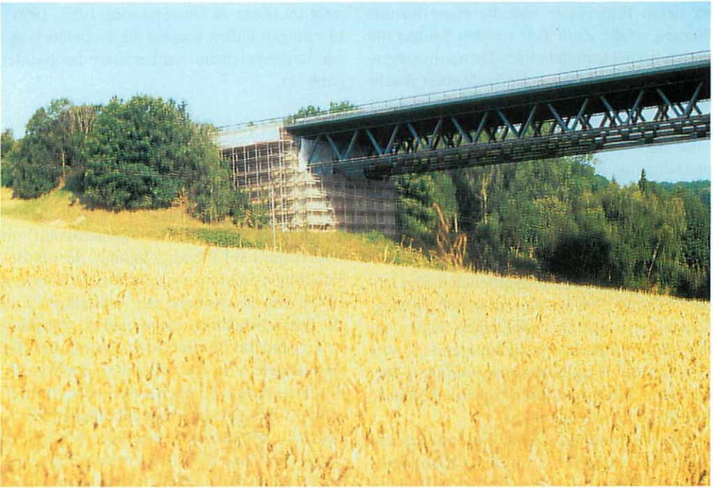
Abb. 2. Bergshäuser Brücke mit eingerüsteten westlichen Widerlagerkammern. Aufn.: JOHN BARZ
