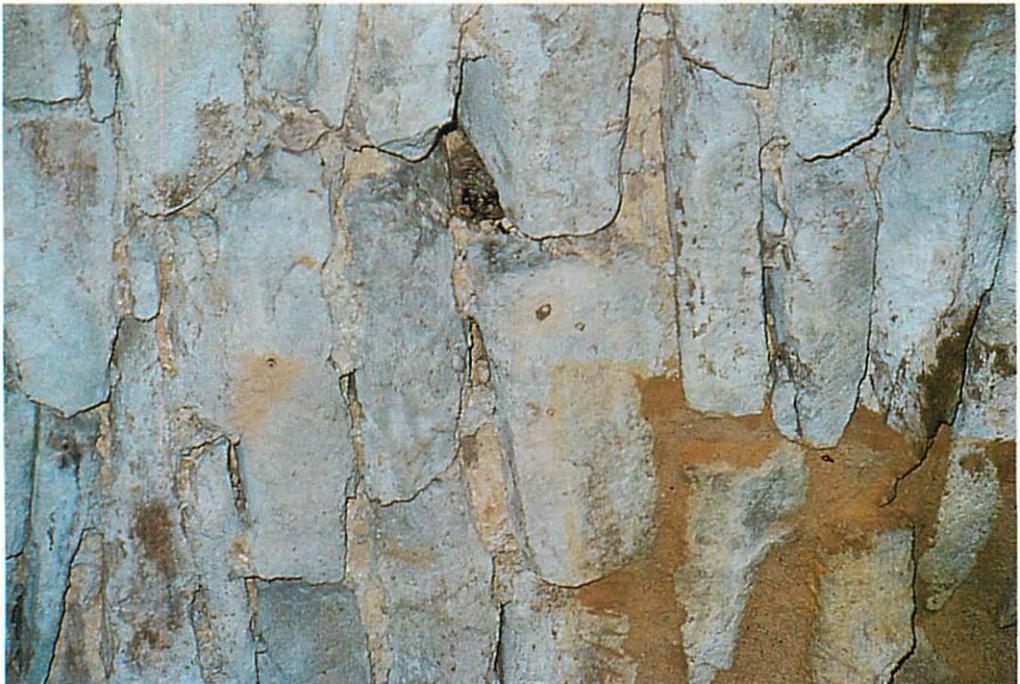
Abb.7. Detailaufnahme von einem neu verfugten und einem nicht verfugten Bereich. Im Spalt in der Bildmitte oben haben sich bereits wieder zwei Fledermäuse eingefunden. Aufn.: H. MAUS
