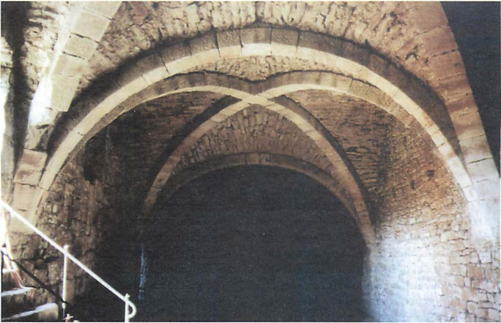
Abb.6. Blick in den Gewölberaum. Die neu verfügtene Bereiche (über dem hinteren Bogen) sind an der dunklen Farbe zu erkennen. Aufn.: H. MAUS
