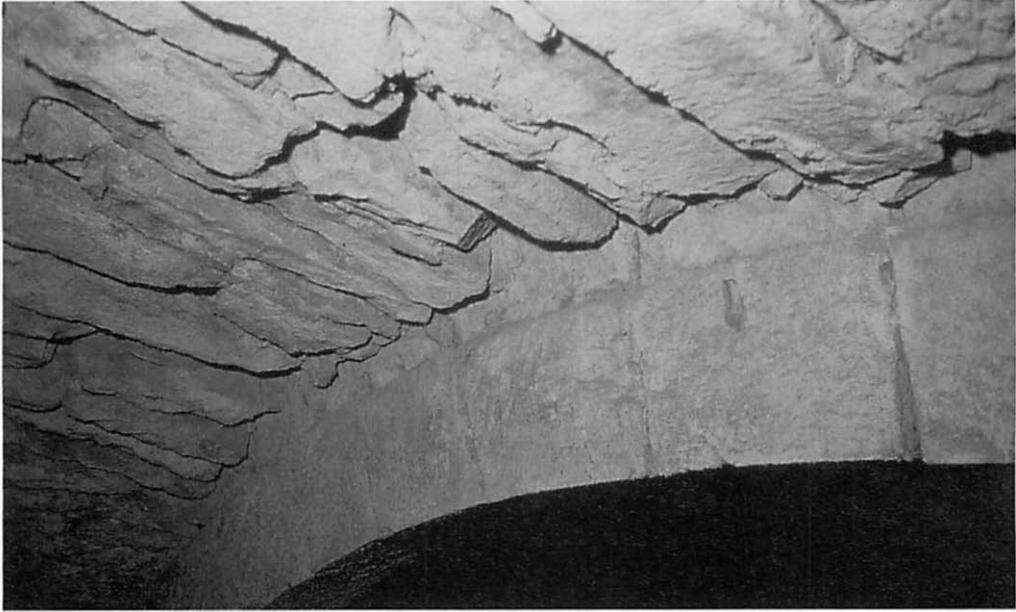
Abb.4. Detailaufnahme einer Kappe mit Gurtbogen. Deutlich sind die starken Mörtel auswaschungen in den Fugen auszumachen. Aufn.: H. MAUS
