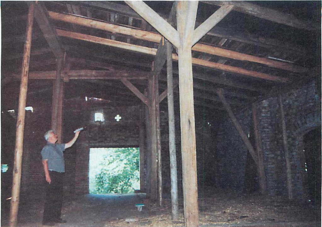
Abb. 3. Konstruktion des luftigen Dachbodens mit Stützverstärkungen und nachträglich eingebrachten zusätzlichen (hellen) Dachbalken. Aufn.: O. BÜXLER
