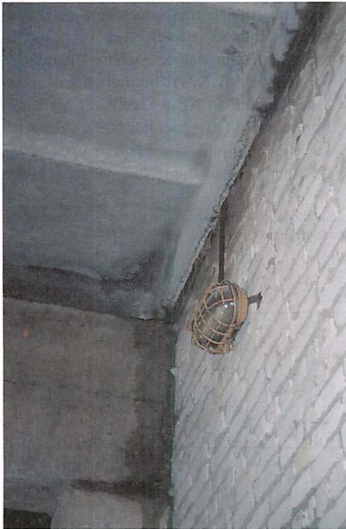
Abb. 10. Spalte zwischen Beton-Segmenten und Außenmauer, in der sich 1998 die kleine Mausohr-Wochenstube befand.
