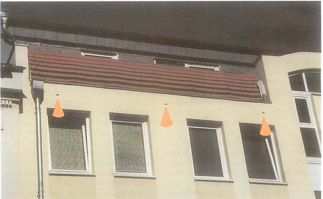
Abb. 1. Rostock, Friedrichstraße 12 – straßenseitige Gebäudeteilansicht: Die Pfeile weisen auf die Einflüge zu den Ersatzquartieren im oberen Gebäudebereich. Aufn.: U. HERMANN'S
