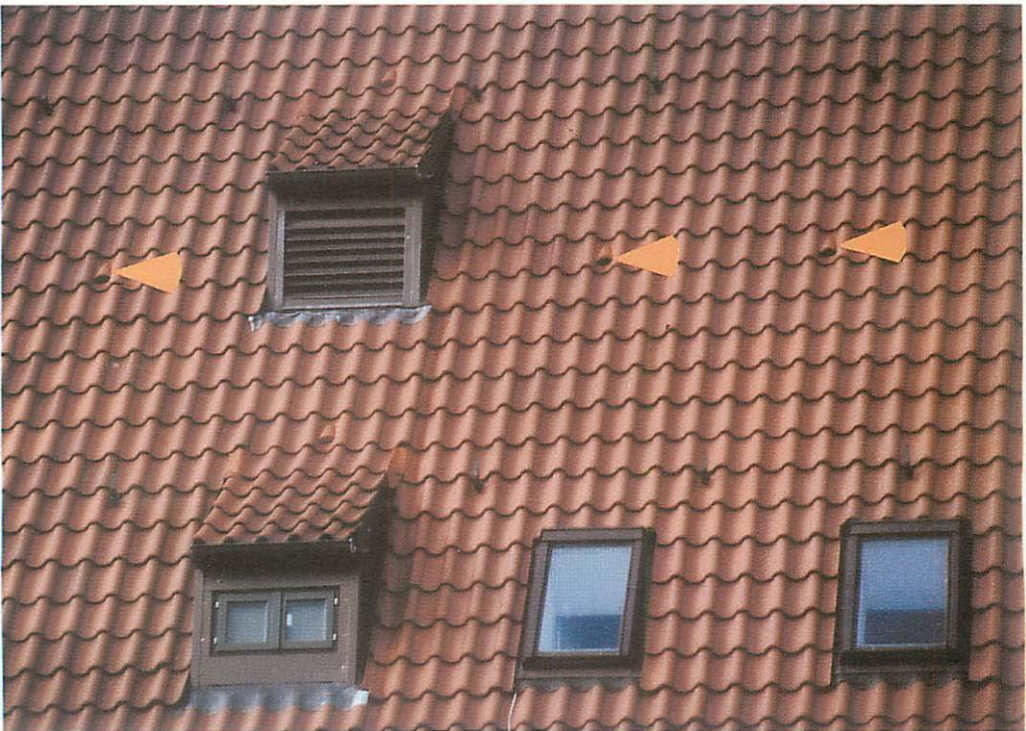
Abb. 15. Rostock, Michaeliskirche, Altbettelmönchstraße – Nahaufnahme mehrerer Einflüge zu den dahinter liegenden Spaltenquartieren (Pfeile). Insgesamt wurden 16 Spaltenquartiere (hof- und straßenseitig) im Gebäude- dach eingebaut. Aufn.: U. HERMANNs
