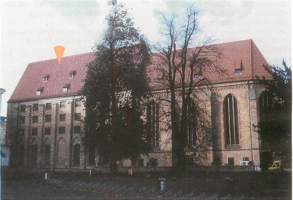
Abb. 14. Rostock, Michaeliskirche, Altbettelmönchstraße – Hofansicht der rekonstruierten Kirche. Die Ersatzquartiere sind im linken Dachbereich untergebracht (Pfeil), Aufn.: U. HERMANNs
