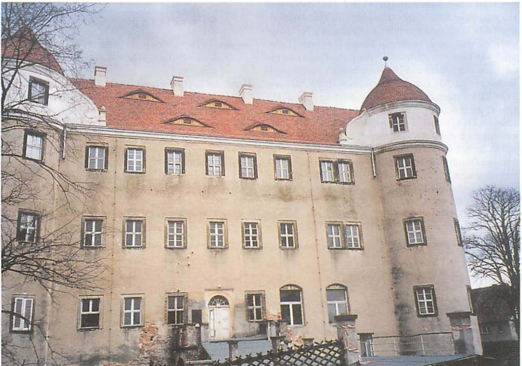
Abb. 1. Schloß Großkmehlen mit 5 neuen Fledermausgaupen. Aufn.: GISELA UHL., auch alle weiteren Fotos.
