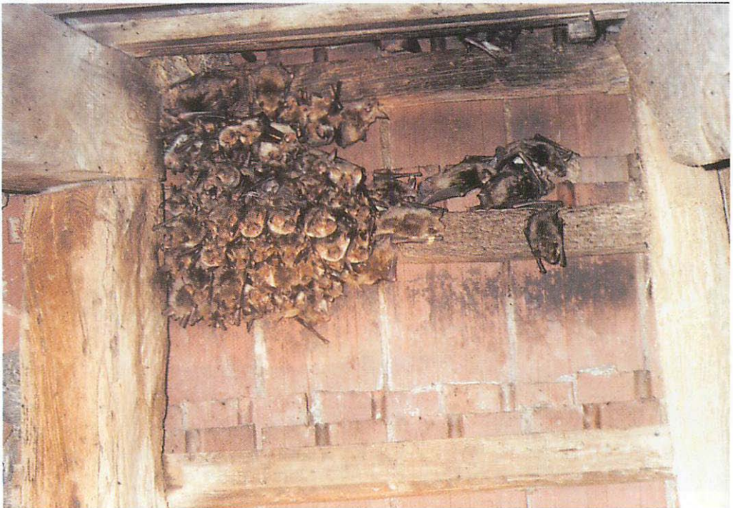
Abb. 4. Mausohr-Wochenstube im Schloß Großmehlen vor den Baumaßnahmen gegen Mitte Mai 1999.
