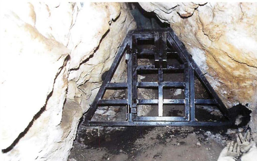
Abb. 3: Das Verschließen der Gyurkó-lápa-Höhle. Aufn.: P. GOMBKÖTÖ
