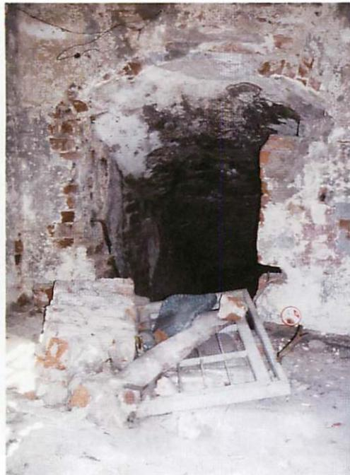
Abb. 7: Herausgebrochene Stahlgittertür am Eingang des Kellergewölbes. Aufn.: S. HAHN
