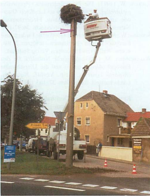
Abb. 1. Weißstorchhorst in Reichenhain unmittelbar vor der Abtragung. Der Pfeil kennzeichnet das Fledermausquartier. Die Braunen Langohren ( Plecotus auritus ) saßen im U-Profil bis unter die Horstunterlage heran. Aufn.: W. HÖNTZSCH
