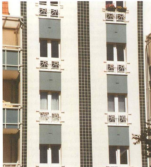
Abb. 5. Quartierzugänge für Fledermäuse im WDVS. Aufn.: J. BERG
