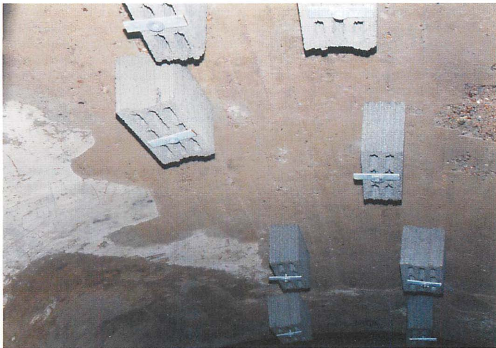
Abb. 2. Die Decke des Gewölbes im Großhansdorfer Quartier mit etwas unregelmäßig angebrachten Hohlblocksteinen. Aufn.: A. KLUPSCH
