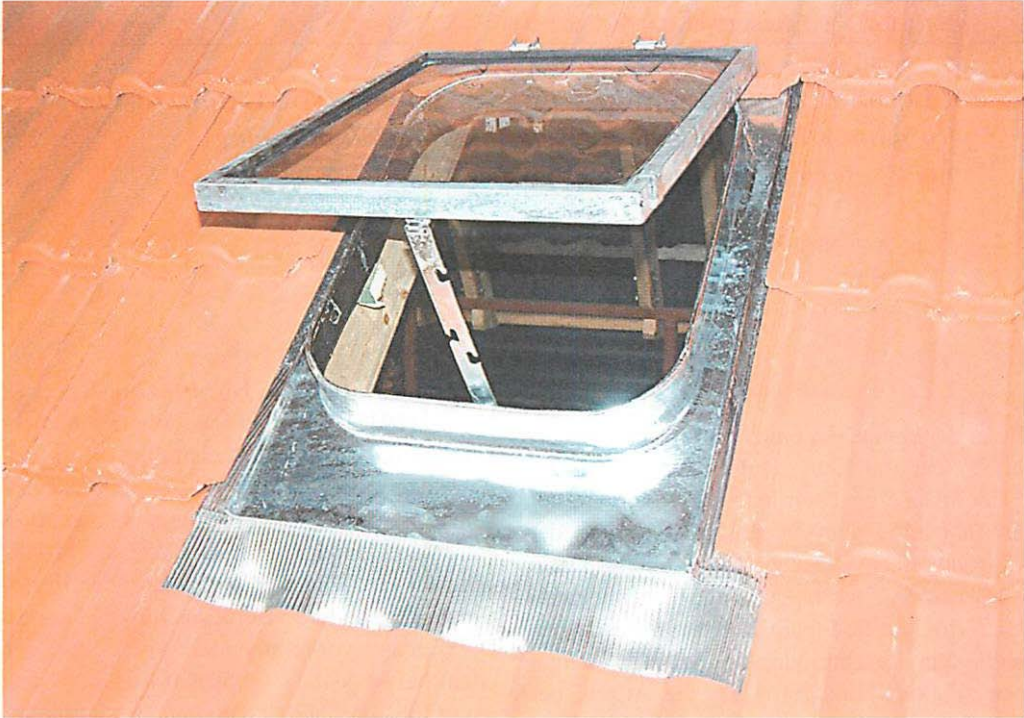
Abb. 4. Nachrüstoption. Austausch des ESG-Öberfensters gegen das der Ausführung 1 oder 2. Aufn.: Jörg REMANN.
