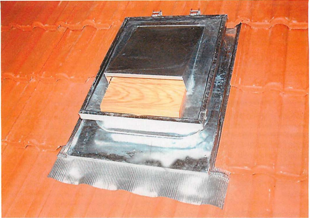
Abb. 1. Fledermaus-Dachdurchgangsfenster Modell Stratmann. Ausführung I für Glattnasen ( Vespertilionidae ). Aufn.: JÖRG REIMANN
