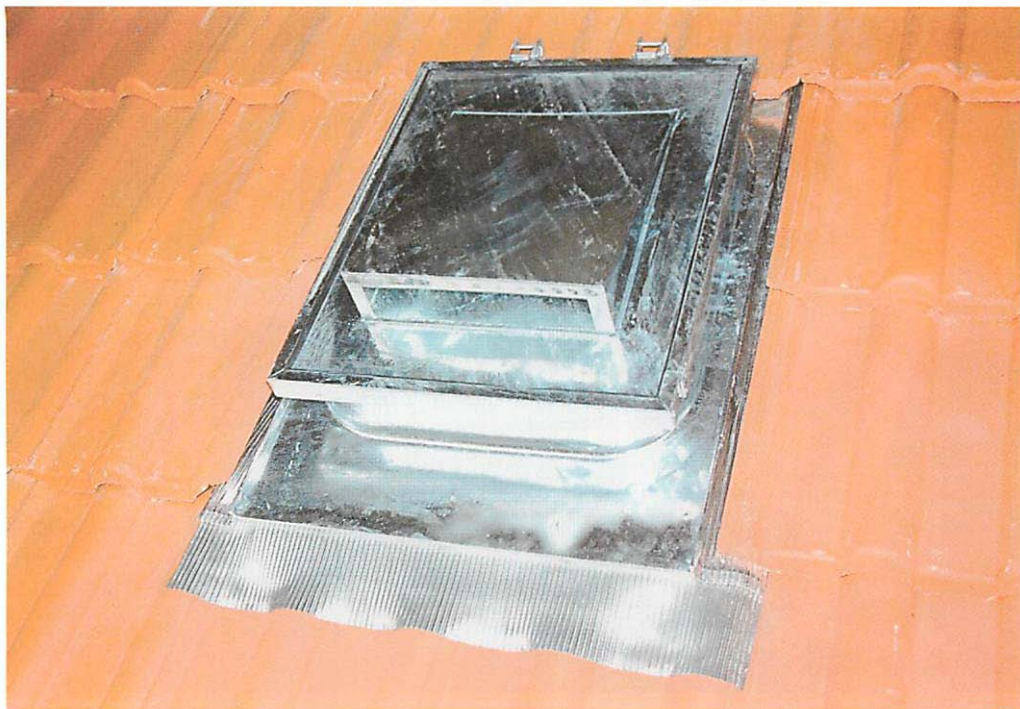
Abb. 3. Fledermaus-Dachdurchgangsfenster Modell Stratmann, Ausführung 2 für Hufeisennasen ( Rhinolophidae ). Aufn.: JÖRG REIMANN
