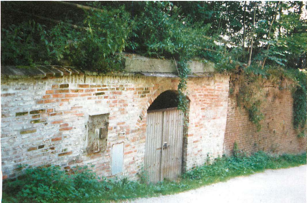
Abb. 2. Der Eingang zum Keller in der Bernlochner Schlucht ist oberhalb der Holztür mit einem Eisengitter als Einflugöffnung für Fledermäuse verschlossen. Aufn.: BERNHARD HÄCK
