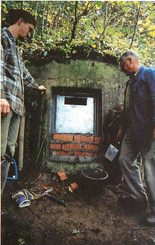
Abb. 10. Einbau des „Fledermaustores“ im oberen Drittel des „Fledermaussilos“. Aufn.: BERNHARD HACK
