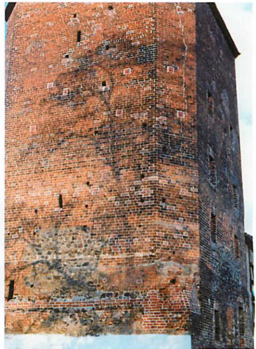
Abb. 4. Bei der Sanierung des Turms der Burg Beeskow wurden neben Dohlenbrunnischen auch Fledermaus- und Mauerseglersteine eingelassen, 20.IV.1994. Aufn.: Dr. A. SCHMIDT
