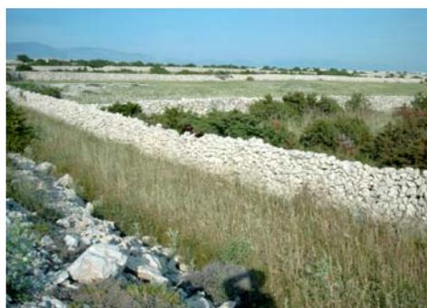
Legesteinmauern zur Weidenbegrenzung und Reduzierung der Windgeschwindigkeit (Foto: M. SCHWEIGER)
