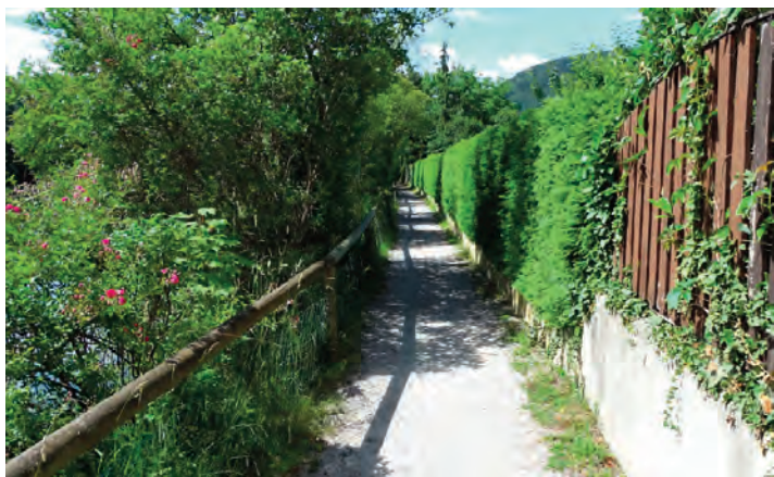
Abb. 4: Platzmangel beim Hochwasserschutz in Frohnleiten.
