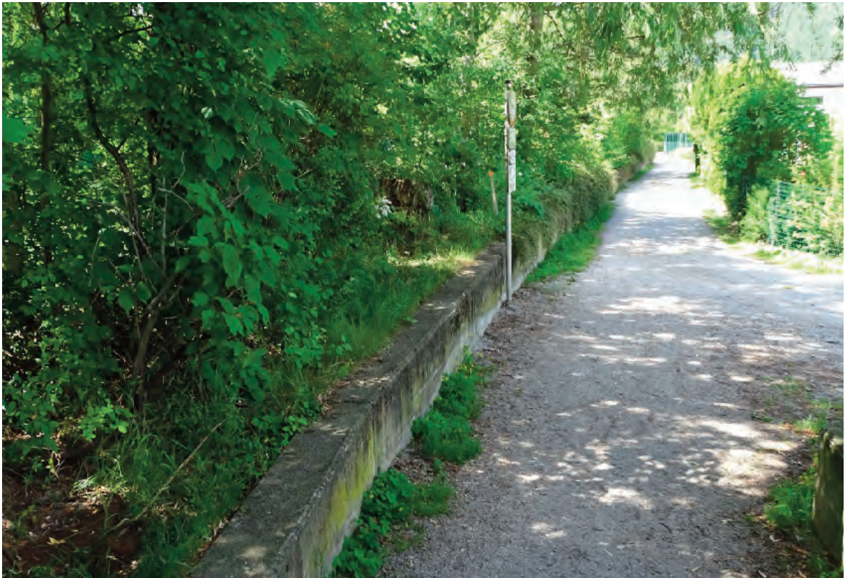
Abb. 7: Aufständigung des "Reptilienschutzzaunes" auf bestehende Betonsockel.
