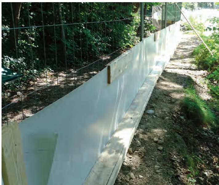
Abb. 9: Schutzzaun im Hochwasser gefährdeten Bereich: Verschraubung an ein eingegrabenes Brett. Im Hintergrund ein ausgelegter „plot“.
