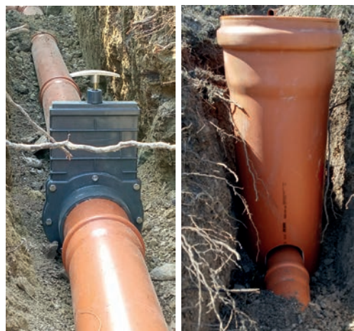
Abb.5 & 6: Abflussrohr mit Schieber zum Entleeren eines Teiches (li), ein Rohr-Schacht mit Deckel wird über den Schieber gestellt, um den Schieber zugänglich zu halten.
