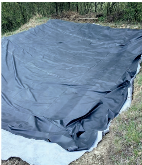
Abb. 3: Teichgrube von Abb. 2 mit Vlies zum Schutz vor Steinen und Wurzeln und ausgebreiteter EPDM-Folie.
