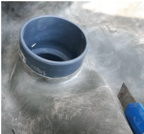
Abb. 7: Folie mit eingeklebtem Abflussrohr. In die Folie wird ein kreisrundes Loch mit einem Durchmesser, der um 3 - 4 cm kleiner als der Rohrdurchmesser ist geschnitten, die Folie erwärmt, anschließend gedehnt und über das Rohr gezogen und verklebt.
