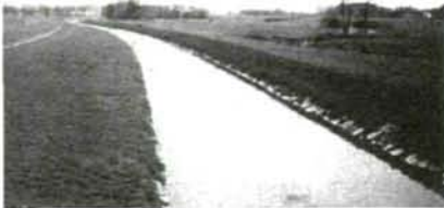
Einziger Lichtblick an diesem regulierten Abschnitt der Pram: Das flache Ufer (rechtsufrig) steht relativ oft unter Wasser, so daß sich hier möglicherweise ein schmaler Streifen Feuchtwiese entwickeln könnte.
