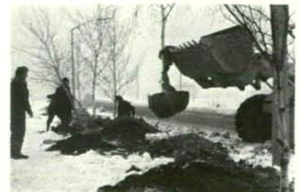
Vorsichtig wird eine Birke nach der anderen samt Wurzelballen vom Standort entfernt.
