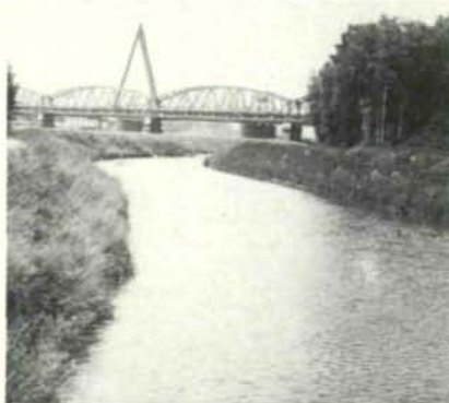
Umleitungsgraben bei der Steyregger Brücke (Juli 1980)
