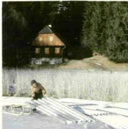
Verlegen der Eternitplatten auf Eis als wesentliche Arbeitserleichterung.
