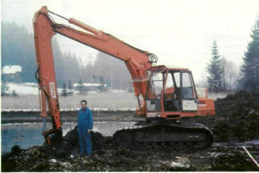
Einsatz des Moorbaggers bei der Schaffung der Seichtwasserfläche I.
