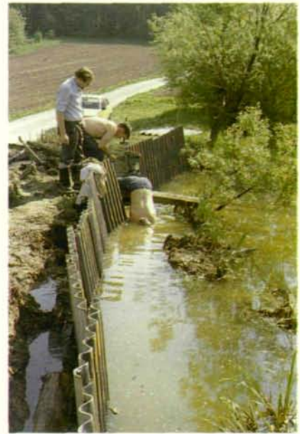
9. 5. 1981: Teichabdichtung mit einer Doppelreihe Welleternit.
