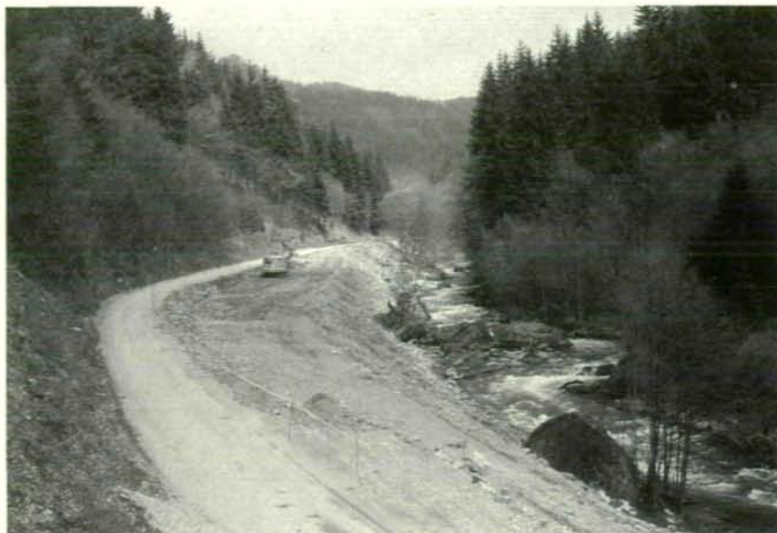
Abb. 1: Talabschnitt N von Reichenstein nach dem Angriff der Bulldozer. Es hat zwar sicher einiges an Steuergeld gekostet, aber dafür war es wenigstens ein voller Erfolg: Die angerichteten Schäden sind nicht wiedergutzumachen. Autoschlangen wurden auf der kaum befahrenen Straße übrigens auch vorher nie gesichtet.
