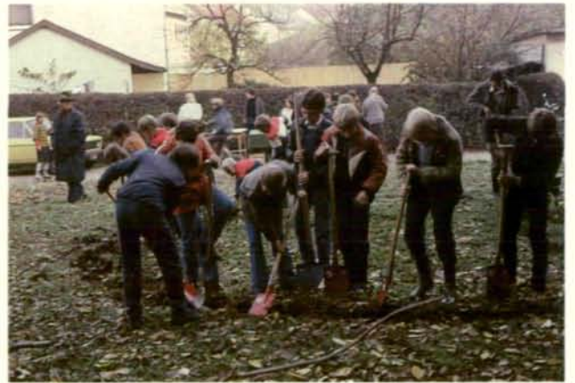
Abb. 5: Die Naturschutzjugend (der Hauptschule) Haslach beteiligt sich mit großem Eifer an den Aushubarbeiten. Die Buben beginnen gerade mit dem Ausstechen der Rasenziegel. An der Straße bieten die jungen Naturschützer Informationsmaterial zum Tümpelbau und Naturschutzliteratur an.
