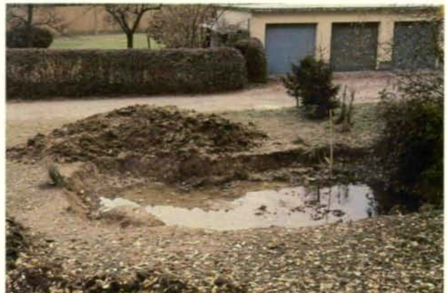
Abb. 9: Eine Woche später: Der Teich ist fertig und teilweise mit Wasser gefüllt. Eine Folienabdichtung wird wahrscheinlich aufgrund des wasserstauenden Lößlehms nicht notwendig sein. Dies erspart Zeit und Arbeit. Der roh aufgeschüttete „Eidechsenhügel“ hat Formen angenommen.
