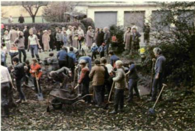
Abb. 8: Der künftige Teich gewinnt zunehmend an Tiefe, das Aushubmaterial wird zu einem „Eidechsenhügel“ aufgeschüttet. Eine große Zahl Schaulustiger aus der Umgebung beobachtet interessiert das Baugeschehen.
