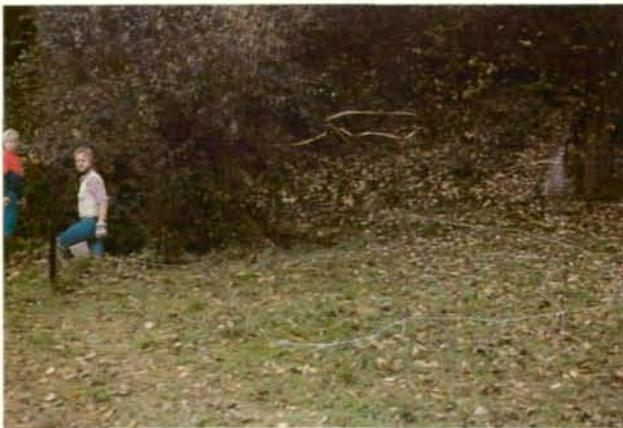
Abb. 4: Die Umrisse des geplanten, z. T. in der Sonne liegenden größeren Teiches wurden mit weißer Schnur abgesteckt. Links Herr G. Bründl beim Ausschöpfen des ursprünglichen Teiches.
