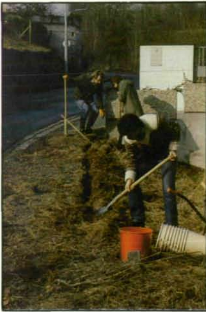
Abb. 3: Die Rasendecke wird vor der Aufstellung des Fangzaunes abgehoben, um die Plastikfolie im Erdreich zu verankern und damit ein Unterkriechen zu verhindern.
