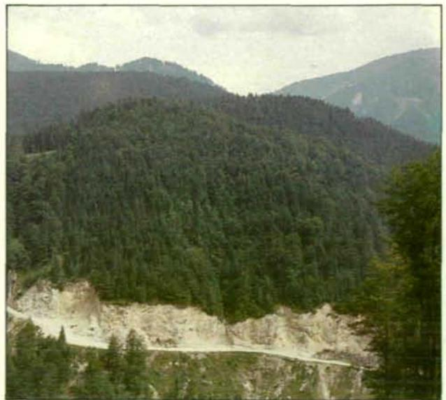
Abb. 3: Brutaler Forststraßenbau an der Hörndlmauer. Bei Überstauung der Talwege müßten noch viele solcher Straßen in die Hänge gesprengt werden.
