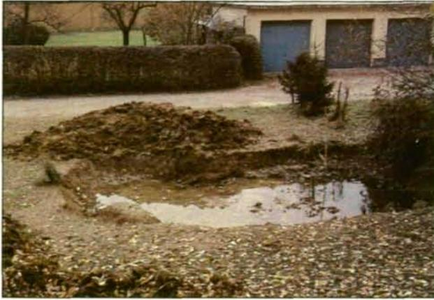
Abb. 1: Modellteichanlage Auberg/Am Teich nach dem Ausgraben. Löß-Lehmboden hält das Wasser.
