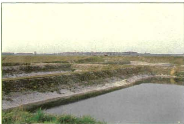
Abb. 14: Steilufrige Kastenteiche mit Wassertiefen von über 60 cm sind bei einem Schutz der Ufer für Graureiher nicht mehr nutzbar.
