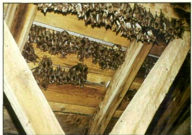
Abb. 2: Eine ungewöhnlich große Wochenstube des Großen Mausohrs befindet sich im Dachgebälk der Wallfahrtskirche Maria Schmoln. Um die Tiere nicht zu gefährden, ist jede Störung möglichst zu vermeiden.
