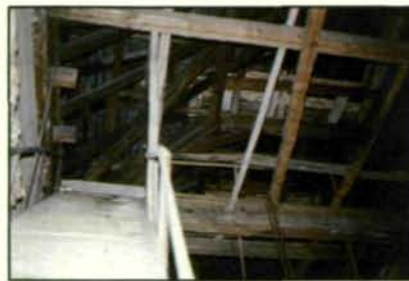
Abb. 1: Alte, wenig begangene Dachbodenräume werden von einigen Fledermausarten bevorzugt als Quartier genutzt. Das Aufspüren von Fledermäusen an diesen Örtlichkeiten ist eine zeitaufwendige und nicht ungefährliche Arbeit, die viel Erfahrung erfordert.
