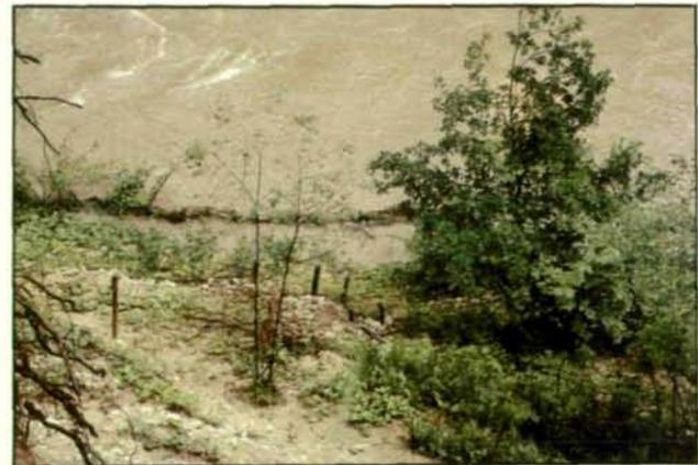
Abb. 8: Bei Hochwasser im Juli 1984 ragt nur mehr die erste Flechtreihe etwas aus dem Wasser. Mit Ausnahme der ca. 6 m hohen Eiche (rechts der Bildmitte) sind alle Jungbäume angepflanzt.
