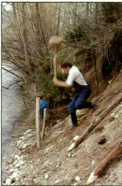
Abb. 4: Beim Bau der untersten Flechtreihe.
