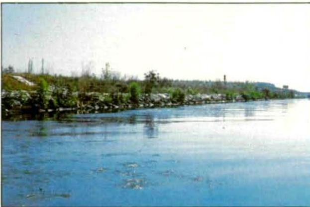
Abb. 13: **Istzustand** – die Donauufer wurden als Folge einer ausschließlich ökonomisch ausgerichteten Bauweise regelrecht eingemauert, die Ufer nicht bepflanzt bzw. naturnahe gestaltet.
