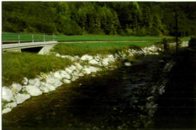
Abb. 7: Gefahr in Verzug: „Naturnahe“ Bachverbauung anno 1986 – begradigt, betoniert und beschleunigt.
