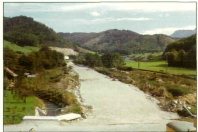
Abb. 3: Die mitten durch das Feuchtgebiet führende Umfahrungsstraße im Bau.
