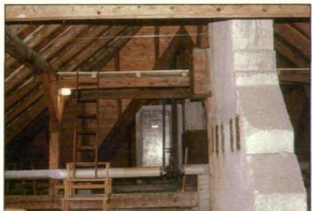
Abb. 7: Oft kann in genutzten Dachböden das Einziehen eines Zwischenbodens unter dem Hangplatz eine geeignete Kompromißlösung darstellen. Auch in einem Linzer Gemeindebau wird heuer versucht, durch das Anbringen eines Zwischenbodens eine für Fledermäuse und Bewohner annehmbare Lösung zu schaffen. Siehe ergänzender Beitrag Seite 27. Foto: W. Pölz
