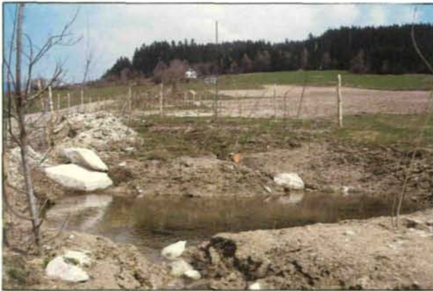
Abb. 5: Anlage eines kleinräumigen Retentionsbeckens.
