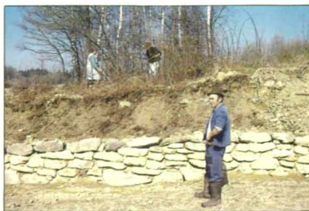
Abb. 10: Zu Mauern aufgeschichtete Steine helfen Böschungen abstützen.
