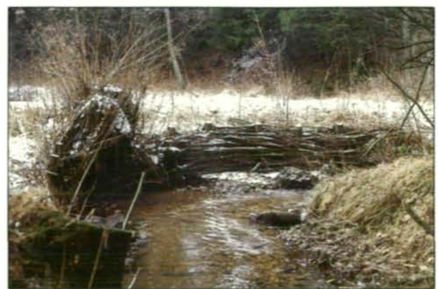
Abb. 2: Die Sanierung dieser Stelle erfolgte mittels Weidenflecht.
