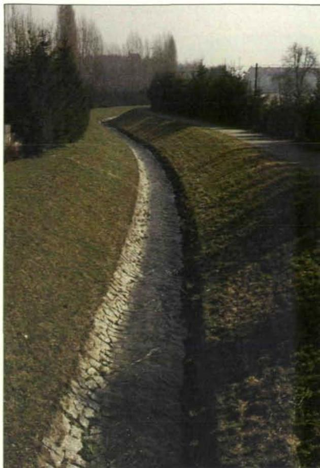
Abb. 6: Hart verbauter Abschnitt des Dießenleitenbaches bei km 1,700. Die Böschungen weisen ein einheitliches Trapezprofil mit gleichmäßiger Grasnarbe bei gleichzeitig fehlendem Gehölzbewuchs auf. Die Sohle ist als gepflastertes aber unverfugtes Wannprofil ausgeführt. Dadurch ist eine zumindest noch geringfügige Verbindung zum hyporheischen Interstitial möglich. Der Abschnitt wurde mit Zustandsklasse 4 bewertet.
