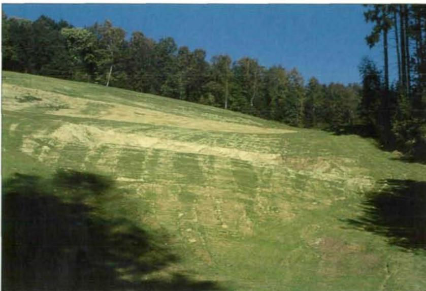
Abb. 5: Die zugeschüttete und planierte Grube, mit Rasensaat und Klee begrünt. 18. 10. 1994
