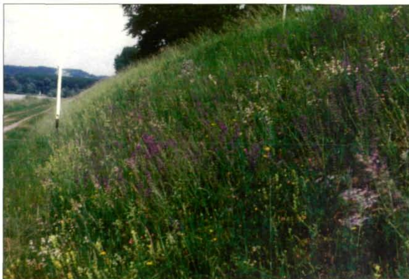
Abb. 4: Die Dammaußenseite im Frühjahr mit artenreichem Trockenrasen.
