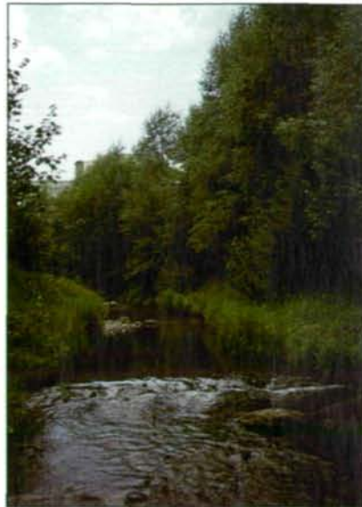
Abb. 5: Haselbach - Steinschwellen zur Verringerung der Strömung; am rechten Ufer Schotterbank sichtbar.
