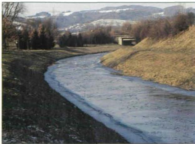
Abb. 8: Das Urfahrner Sammelgerinne vor der Revitalisierung. Vergleicht man den damaligen Zustand mit den im Zuge der Befischung 1996 gemachten Aufnahmen, so ist die deutliche Strukturverbesserung erkennbar. Foto: F. Schwarz
