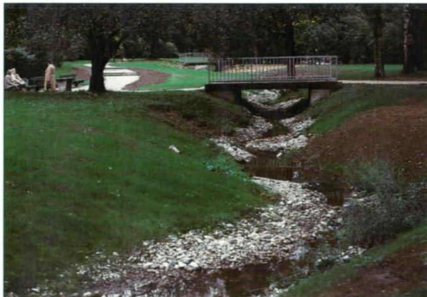
Abb. 2: Der Schießstättenbach kurz nach Fertigstellung der Renaturierung.
