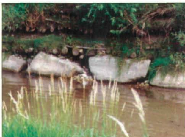
Abb. 11: Urfahrner Sammelgerinne/ Stelle 1 - Uferbefestigung mit großen, unverfügten Steinblöcken.
