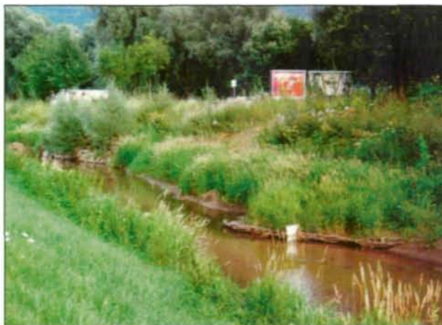
Abb. 12: Urfahrner Sammelgerinne - oberer Bereich (Stelle 1) mit lokaler Uferbefestigung in Form eines Holzverbaues.
