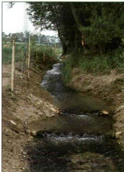
Abb. 16: Vor der Renaturierung verlief dieses Teilstück des Tagerbaches sehr geradlinig und ohne Breitenvarianz. Die Abbildung zeigt den noch „frischen“ Zustand im Mai 1991.
