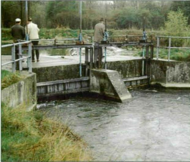
Abb. 5: Lell-Wehr - Ausleitung des gesamten Wassers aus der Krems.
