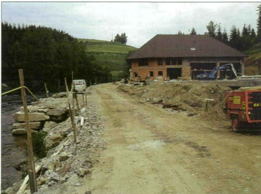
Abb. 1: Nicht nur die Errichtung eines technischen Bauwerkes (hier eine Kläranlage), sondern auch randliche Einflüsse während der Bautätigkeit sind von Bedeutung: vorübergehende Zerstörung eines Flußufers durch eine Baustellenstraße.
